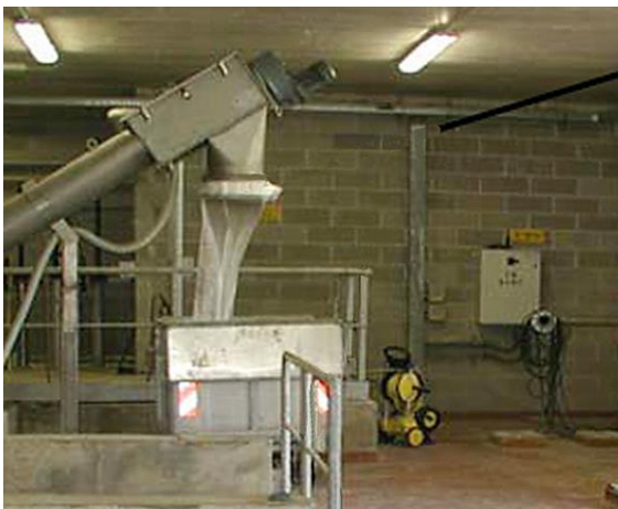
EMD būgninis sietas su nešmenų pakavimo į maišus sistema, išmetantis nešmenis į konteinerį
